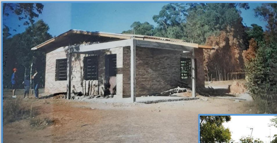
Construção do PA 13 no Bairro Guajuviras
